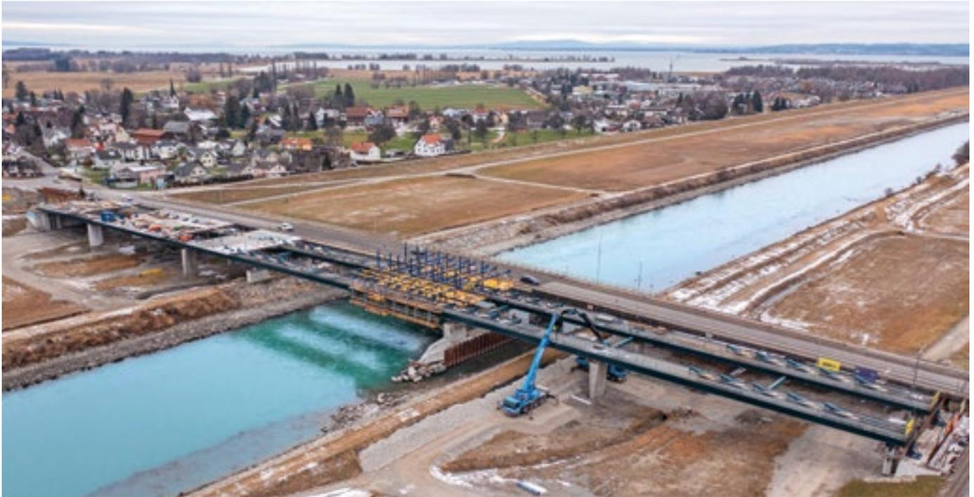
Ein weiterer Meilenstein beim Bau der neuen Rheinbrücke: In den kommenden Monaten werden die Masten und die Überspannung errichtet und die Brücke an die L202 angeschlossen.
